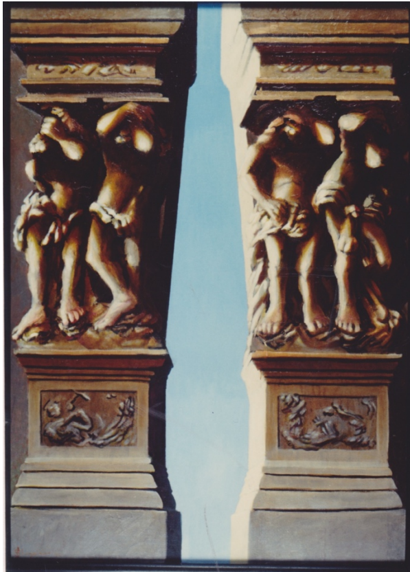
Façade avec atlantes
